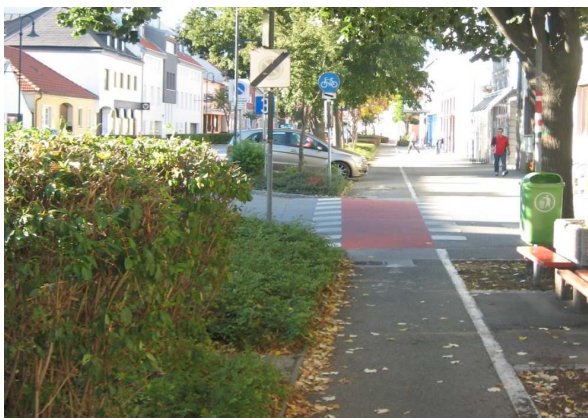
Korneuburger Straße in Langenzersdorf: Die RadfahrerInnen werden hinter Buschreihen versteckt und sind schwer von den AutofahrerInnen zu erkennen.
