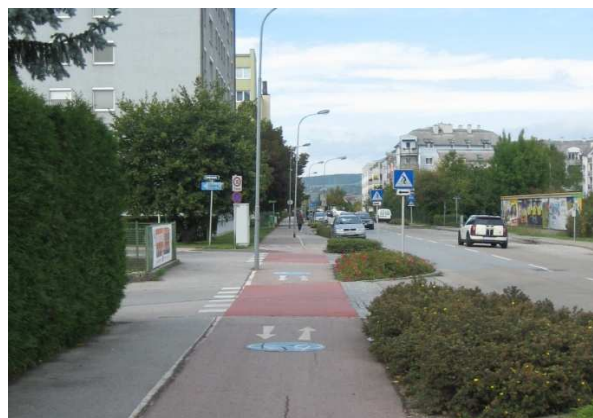
Leobendorfer Straße in Korneuburg: Ein ausreichender Sichtkontakt zu den aus der Querstraße kommenden AutofahrerInnen ist nicht gegeben.
